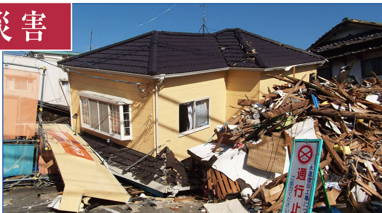
2016年熊本地震・熊本県益城町／撮影：防災士 橋本 茂
